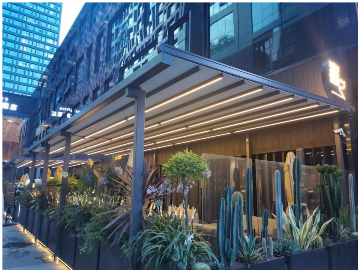
案例名称： 酒吧餐厅拓展区域 固定方式： 立柱支撑式 案例面积： 110m 2
